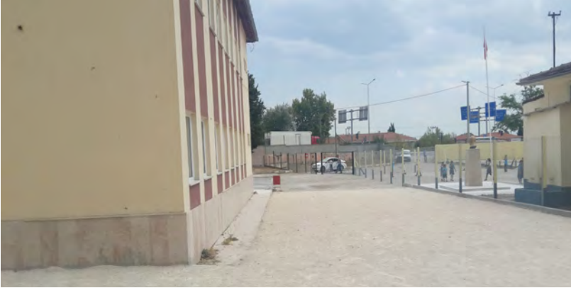
Çalışkanlar İlkokulu Beton Bordür ve Parke Döşenmesi
