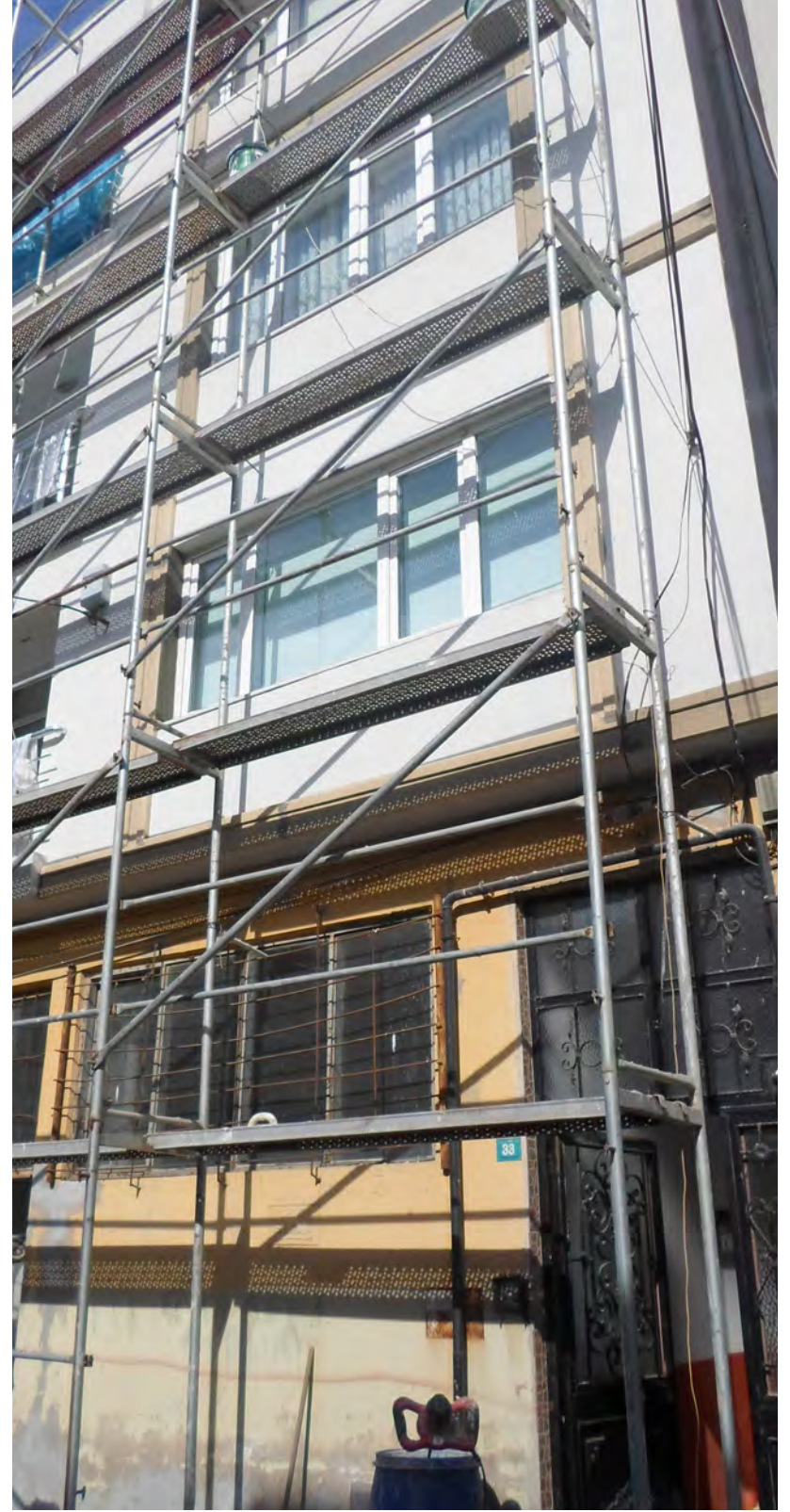
BİNALARDA DIŞ CEPHE MANTOLAMA İŞLEMLERİNİN KONTROLLERİ
