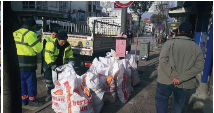
Evlerden Çıkan Tadilat Atıklarının Personel Eli İle Kaldırılması
