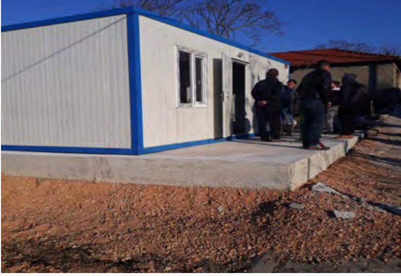
ÇEPNİ MAHALLESİ (Çepni Mahallesinde Evsiz vatandaşın temin edilen prefabrik ev.)
